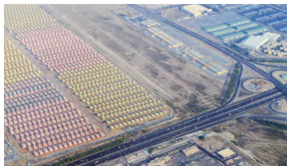
▲写真2 戸建て住宅建設中(ドバイ)
