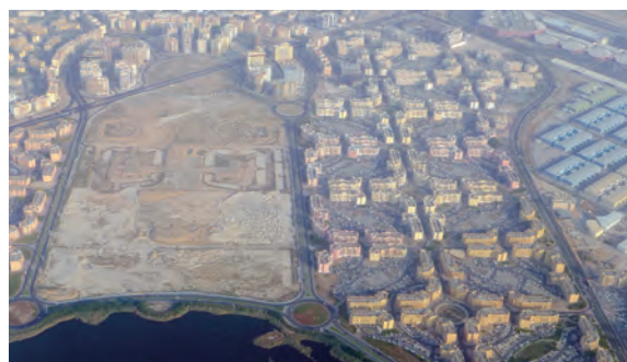
▲写真1 集合住宅建設中(ドバイ)
