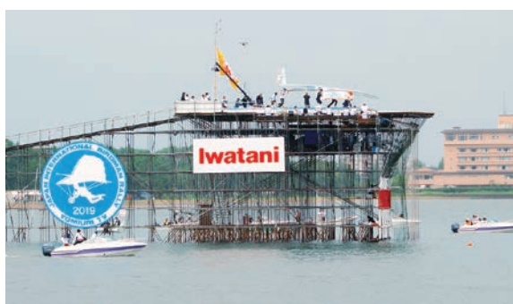
▲図-8 プラットホーム
