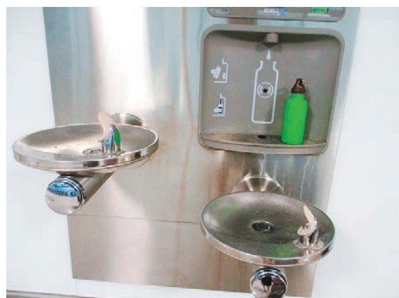
▲図4 プリティッシュコロムビア大学構内の給水機(著者撮影) 水飲み場とボトルへの給水機が併設されている。 ボトルを置くとセンサーが働いて美味しい水を補充できる。
